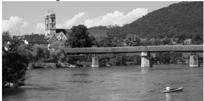
Alte Holzbrücke über den Rhein nach Bad Säckingen
