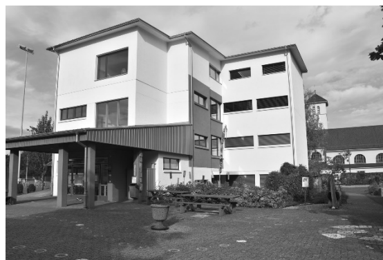
Im Schulhaus wurde die Heizung ersetzt.
