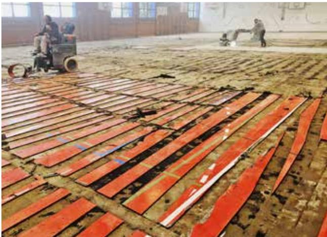
Der fast 15 Tonnen schwere Hallenboden-Belag wird mit einem «Stripper» vom Untergrund gelöst.
