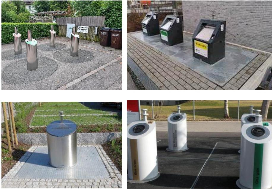
Abbildung 15: Beispiel Unterflurcontainer ohne Pressung.
