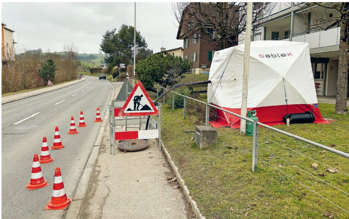
Die cablex AG zieht das Glasfaserkabel ein.
