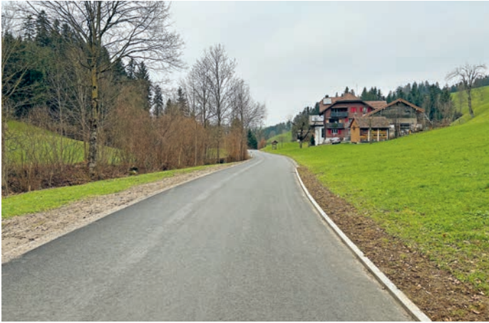
Die sanierte Rohrmattstrasse.
