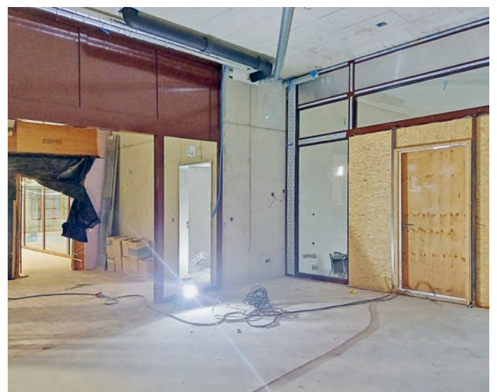
Der neue Eingangsbereich nimmt Formen an.
