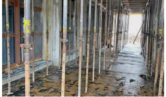
Der Bau der Galerie nimmt Formen an.
