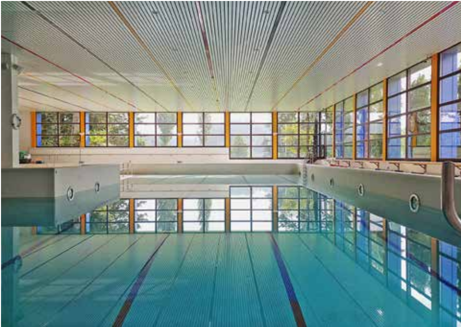
Der Countdown läuft! Die Befüllung des Beckens markiert einen der letzten Schritte vor der Wiedereröffnung des Hallenbades.
