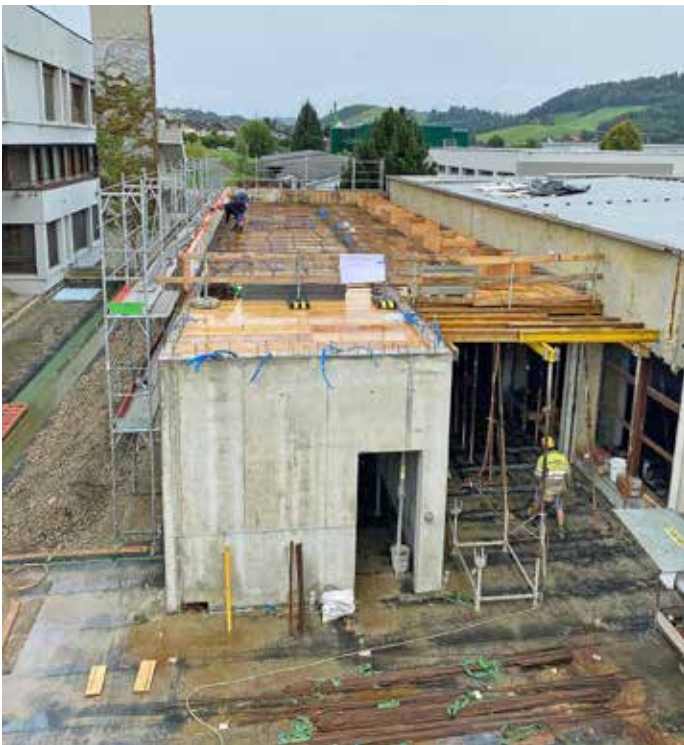
Hier entstehen die neuen Büroräumlichkeiten.
