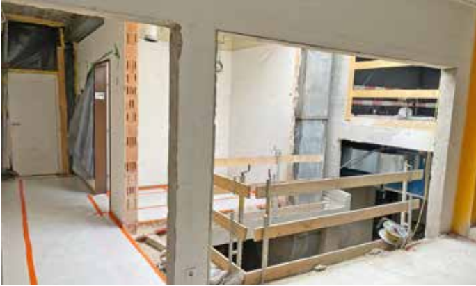
Lifteinbau für den barrierefreien Zugang vom Untergeschoss bis zur Hallenbad-Ebene.
