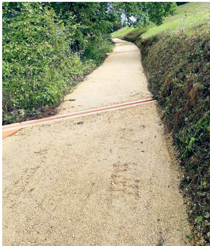
Instand gestellter Fussweg Richtung Haldenstrasse.
