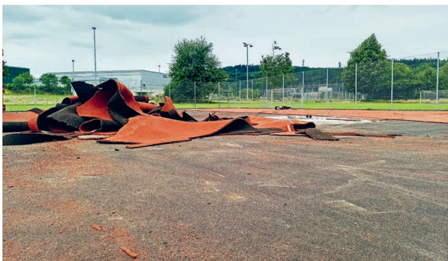
Vom alten zum neuen Belag: Zuerst wurde der bestehende Belag vollständig abgetragen und fachgerecht entsorgt . . .
