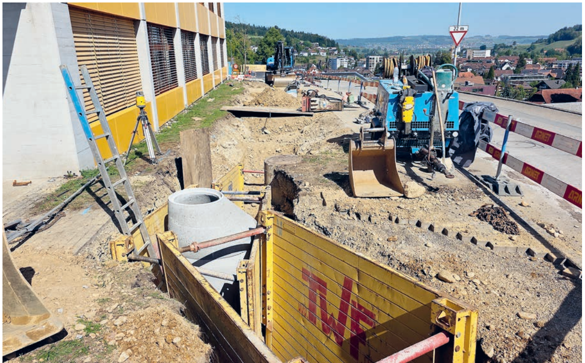
Ersatz der Werkleitungen neben dem Schulhaus Schlossfeld.
