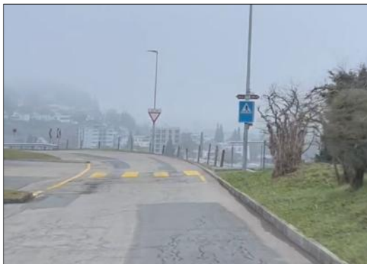
Abb. 18 Annäherungsbereich Ost vom Fussgängerstreifen Schlossfeld ist spät erkennbar
