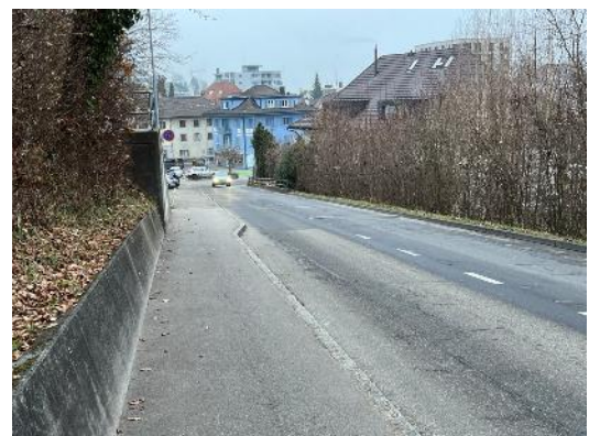
Foto 4 Fahrbahnverbreiterung Höhe Fussgänger Verbindung (Richtung Menzbergstrasse.)
