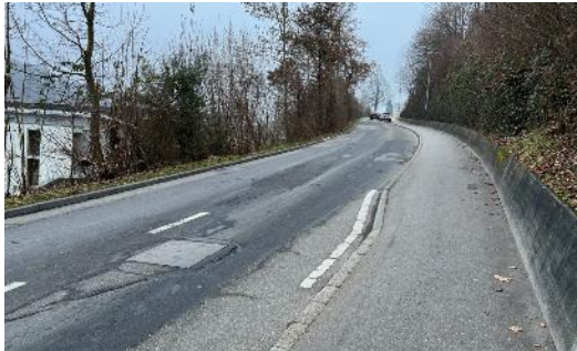
Foto 5 Strassenverbreiterung Nord (Ri. Schlossfeld)
