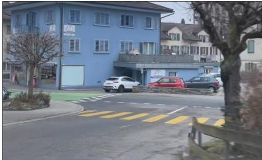
Abb. 17 Fussgängerstreifen bzw. Annäherungsfläche am Knoten Menzbergstrasse ist für talwärts fahrende Fahrzeuge erst sehr spät erkennbar
