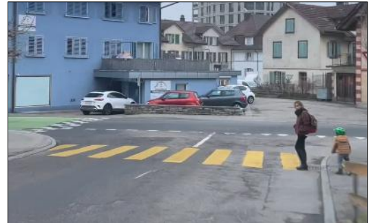
Abb. 17 Fussgängerstreifen bzw. Annäherungsfläche am Knoten Menzbergstrasse ist für talwärts fahrende Fahrzeuge erst sehr spät erkennbar
