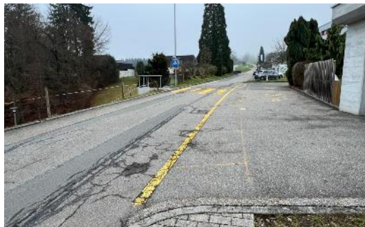
Abb. 19 Ungeschützte Fussgängerführung mit Längsstreifen
