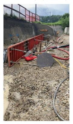
Rossgassmoos Wassereinbruch neues Hochregallager Competec Logistik AG (Sofortmassnahmen Wasser abpumpen und Absprache mit Technischem Dienst) Gefahr, dass Wasser in Trafostation läuft. Grosser Schaden konnte verhindert werden
